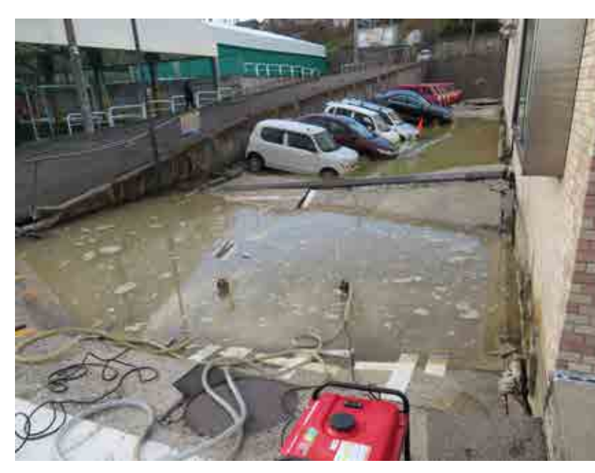
▲液状化現象による沈降と水の噴出（1/2片桐昭彦氏撮影）
