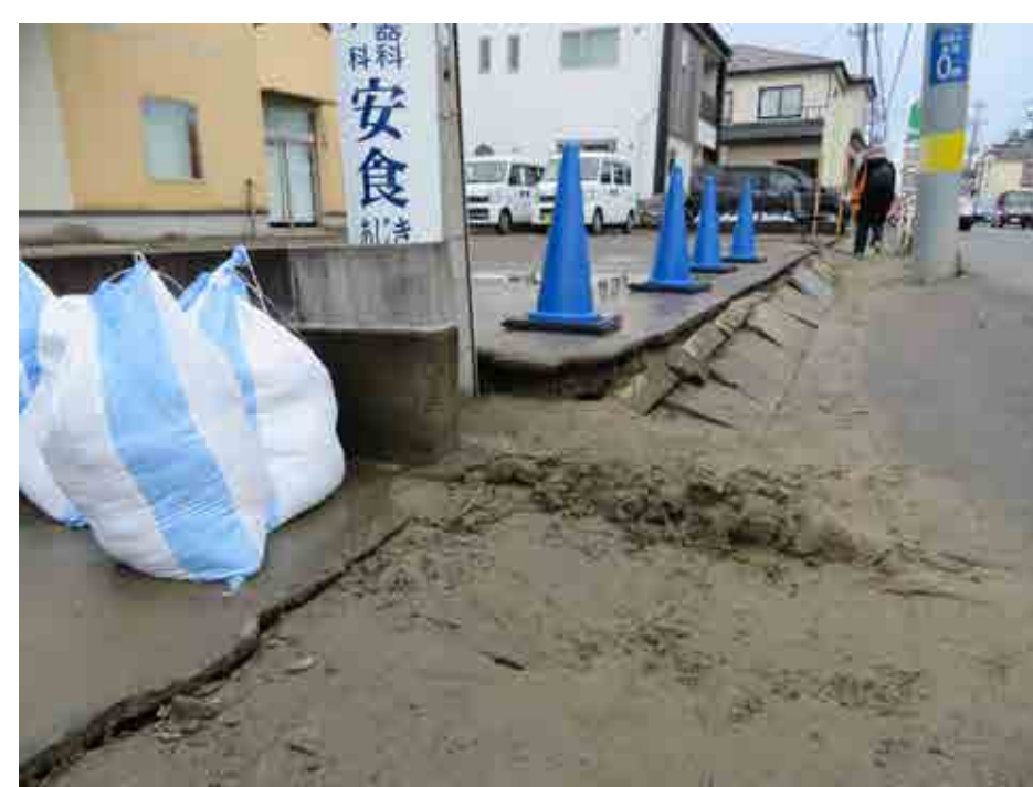
▲液状化現象による噴砂と沈降（1/2片桐昭彦氏撮影）
