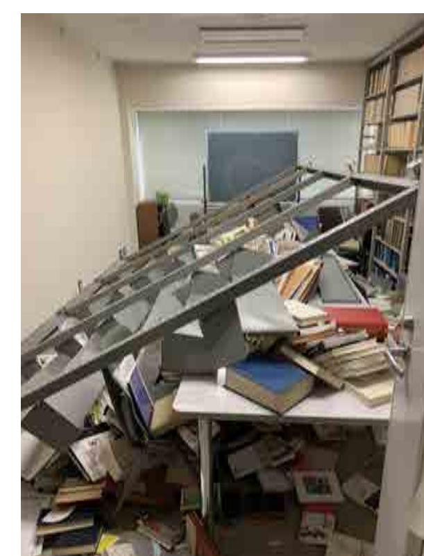
▲固定釘が抜け倒壊した書架（新潟大学）（1/1原直史撮影）
