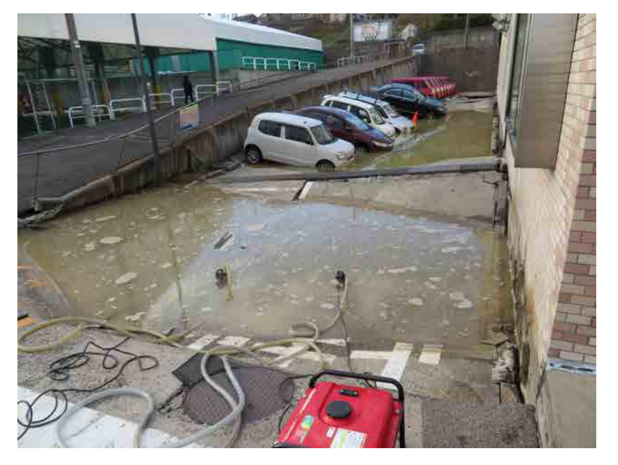
▲液状化現象による沈降と水の噴出（1/2片桐昭彦氏撮影）
