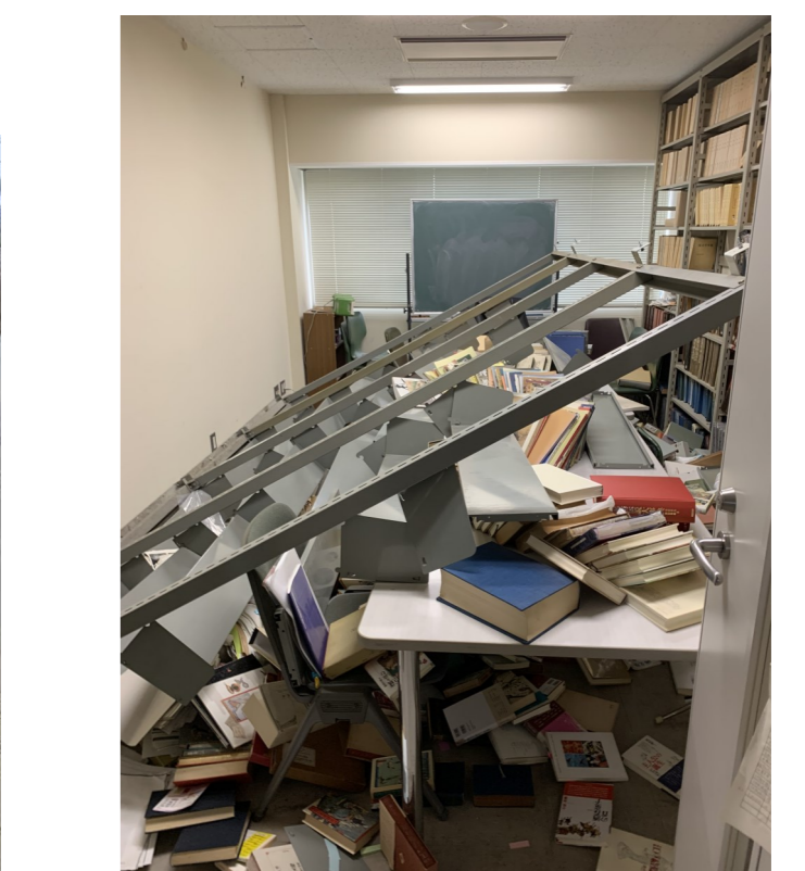
▲固定釘が抜け倒壊した書架（新潟大学）（1/1原直史撮影）
