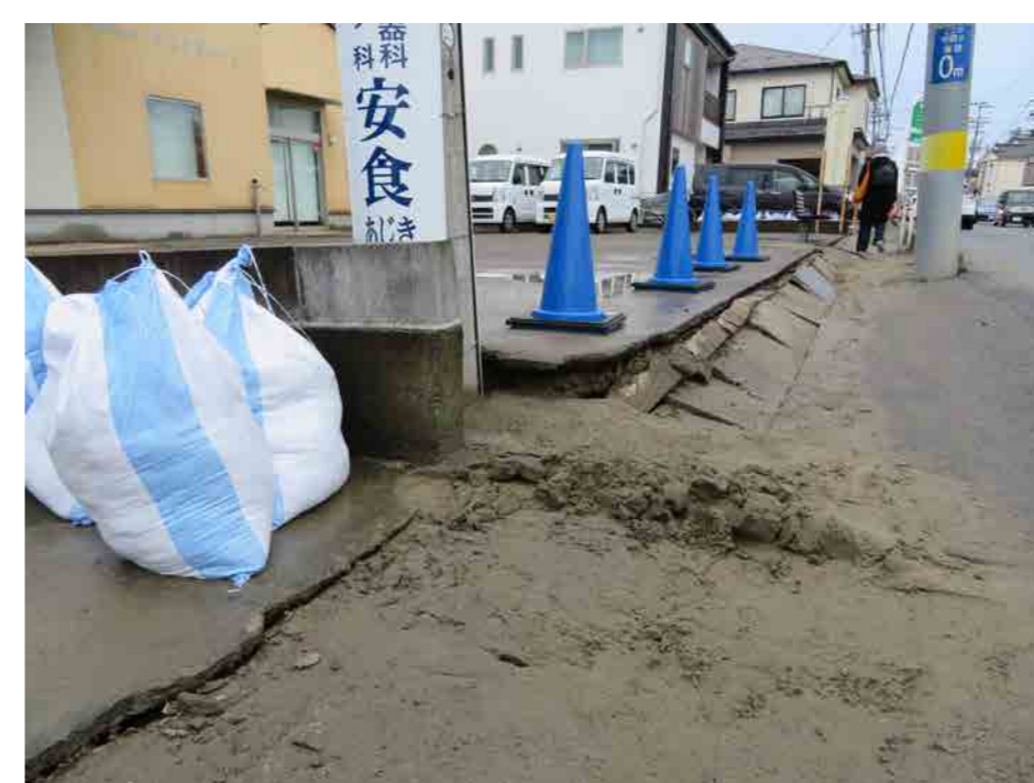
▲液状化現象による噴砂と沈降（1/2片桐昭彦氏撮影）
