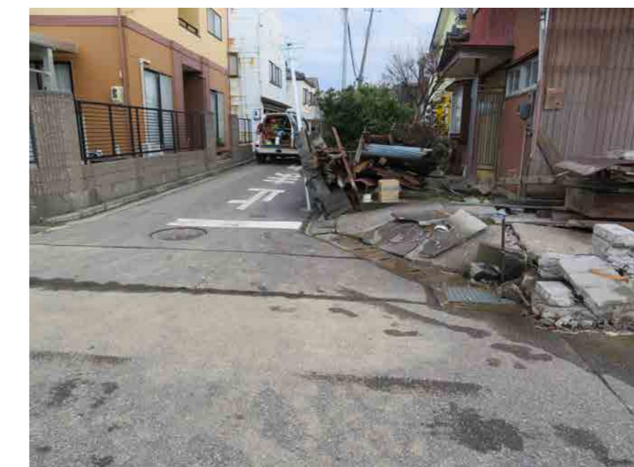
▲基礎崩壊により倒壊した家屋（小屋）（1/2片桐昭彦氏撮影）
