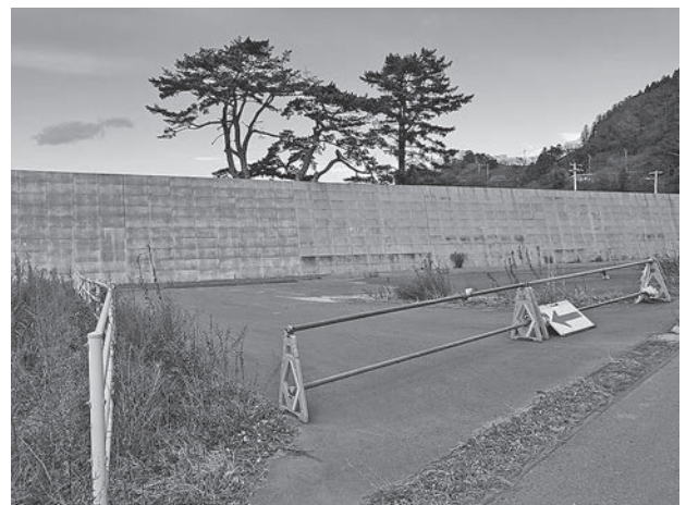
図3-3 防潮堤と松の木（2020年12月6日）
