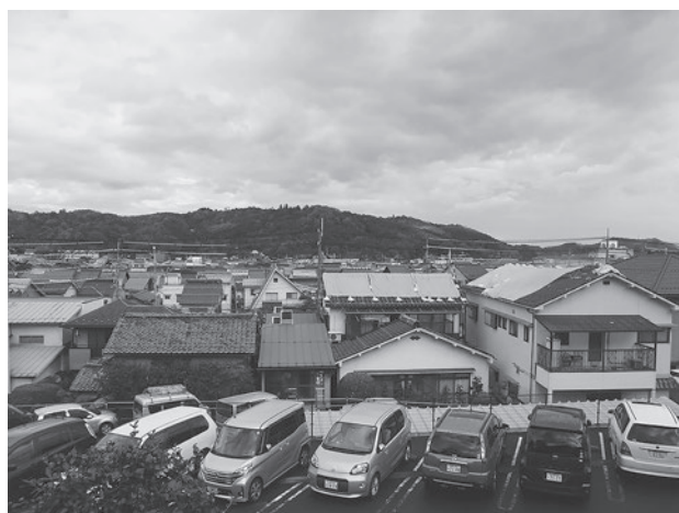
写真5 鳥取県中部地震（倉吉市街地）（11月16日撮影）
