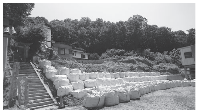
図1: 土砂崩れの発生箇所
