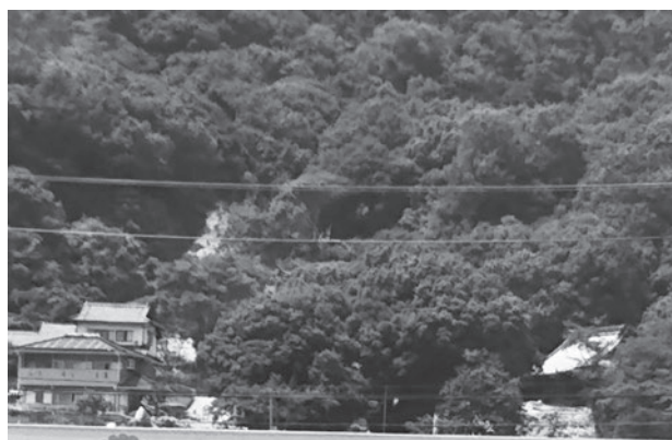
写真① 海田町の神社被災状況
